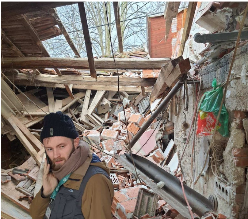
ADRA Mitarbeiter organisiert Hilfe in zerstörtem Gebäude
