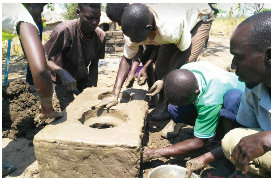
Bau eines Lehmofens
